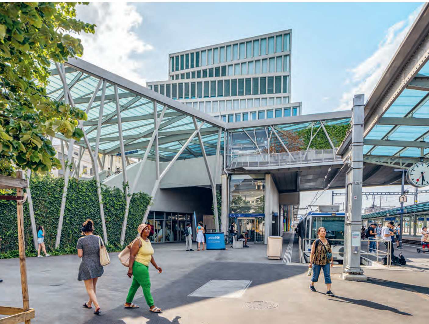
Metrostation und Liftaufgang zur Passerelle. | Station de métro et ascenseur vers la passerelle.
