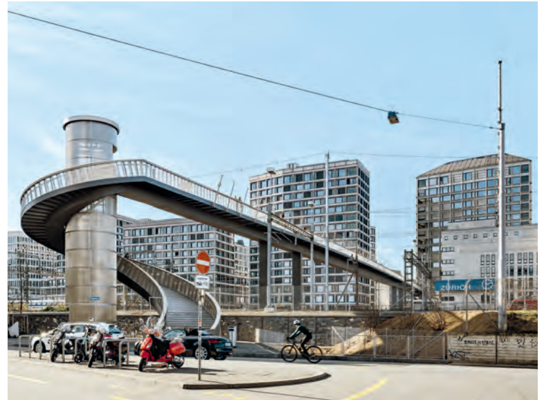
Die geschwungene Treppe lädt zum Begehen ein.
