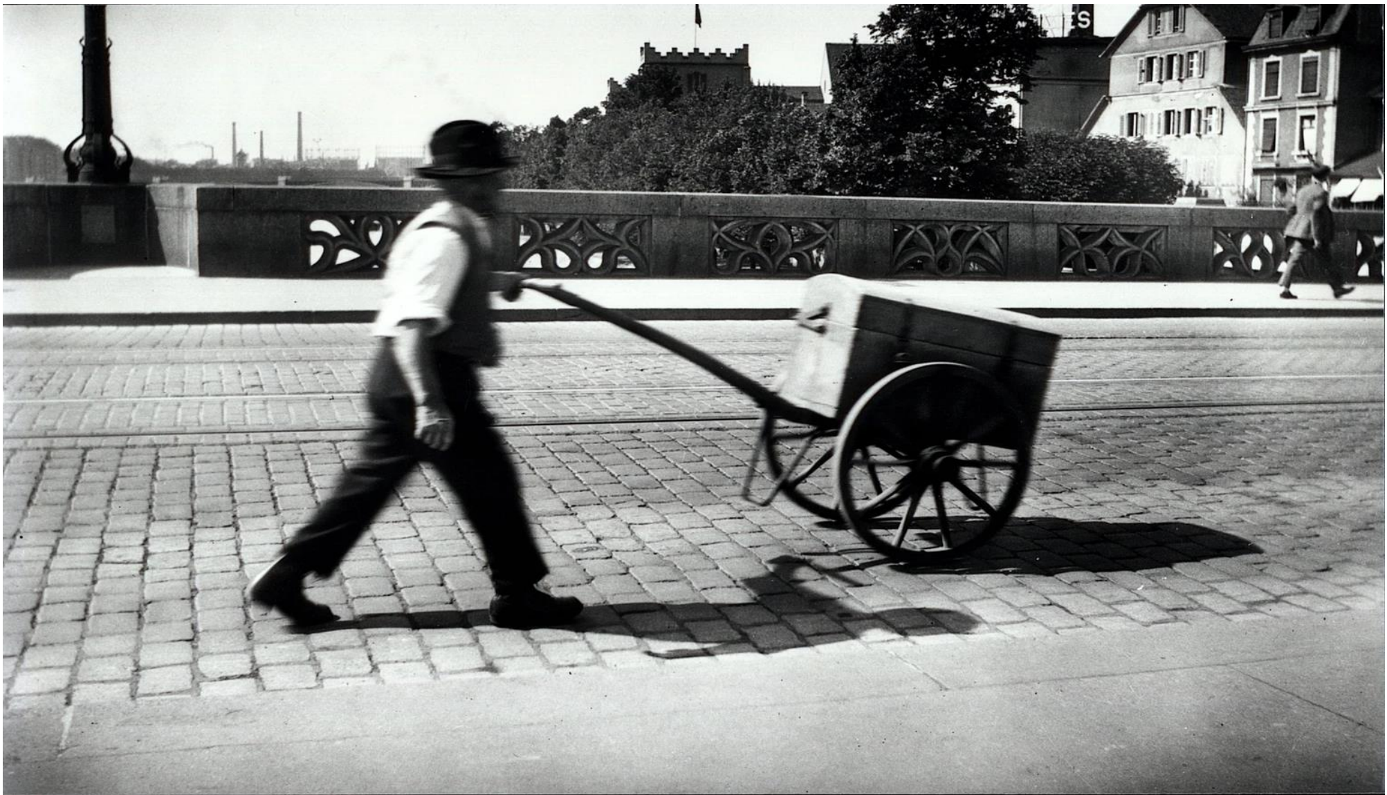
Ein Arbeiter stösst einen Karren mit Abfall, das aus Abwasserschächten stammt, über die mittlere Rheinbrücke von Gross- nach Kleinbasel im Jahre 1899. Ein Jahr zuvor wurde das erste Automobil in der Schweiz zugelassen.
