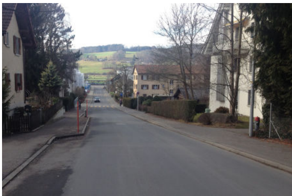
Hauptverkehrsstrasse mit punktueller Einengung, Bonstetten ZH
