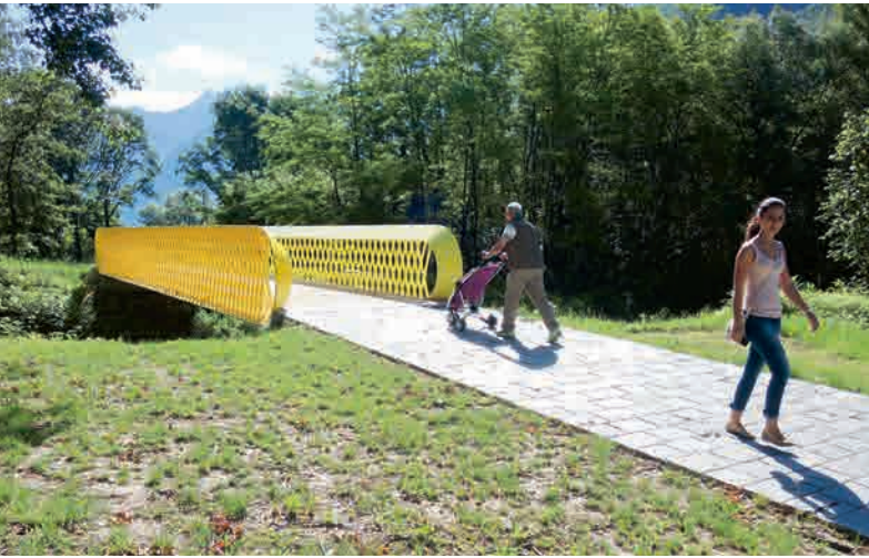
Neue Achse für den Fuss- und den Veloverkehr: Die auffällige gelbe Brücke in der Tessiner Gemeinde Lumino schliesst eine Netzlücke. – Bild: Flâneur d'Or 2014
