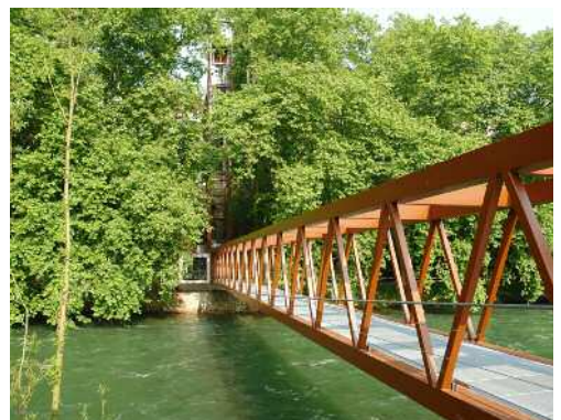
Der 2007 eröffnete Limmatsteg und der dazugehörige Promenadenlift stellen auf schnellstem Weg die Verbindung zwischen Ennetbaden und dem Bahnhofplatz Baden sicher. Bild: Leupi und Schafroth
