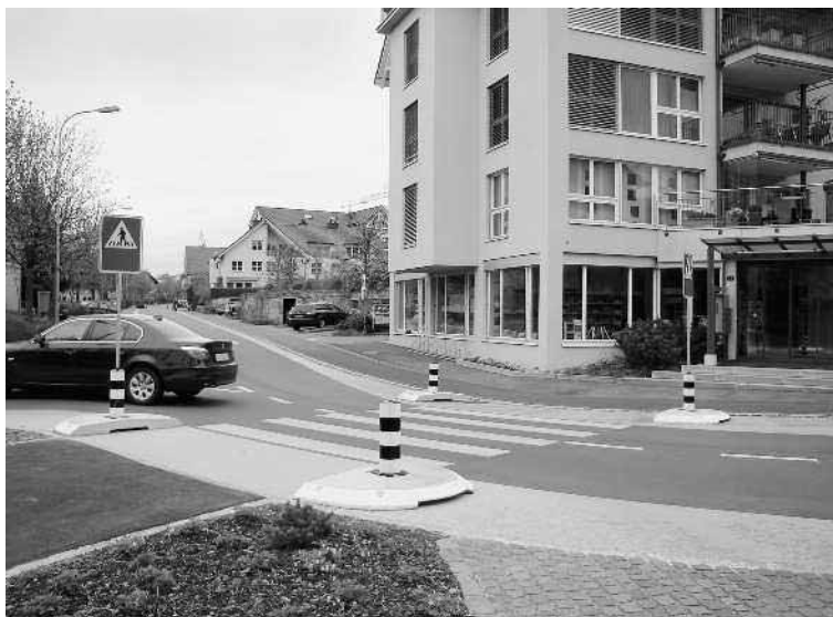
Dort, wo sich im Kernbereich zwei Tempo-30 Strassen treffen, sorgt ein Fussgängerstreifen dafür, dass die Fusswege nicht unterbrochen werden. Bild: Christian Thomas
