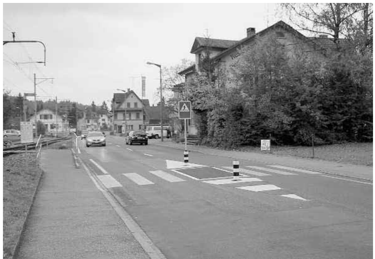
Seetalstrasse in Seon vorher und nachher: Die Fussgängerschutzinsel unterteilt die Fahrbahn. Dadurch kann die Strasse in zwei Etappen gequert werden.
