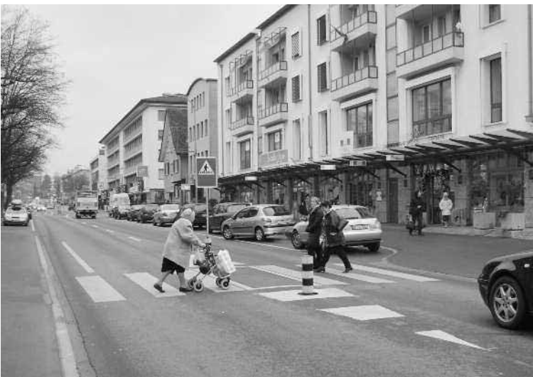
Landstrasse in Wettingen vorher und nachher: Die zwei Inselchutzpfosten und der markierte weisse Streifen werden als «Bauwerk» wahrgenommen.
