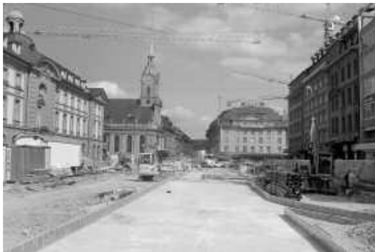
Grossbaustelle Bahnhofplatz Bern (Bubenbergrplatz Blickrichtung Loeb) Bild: Christian Thomas
