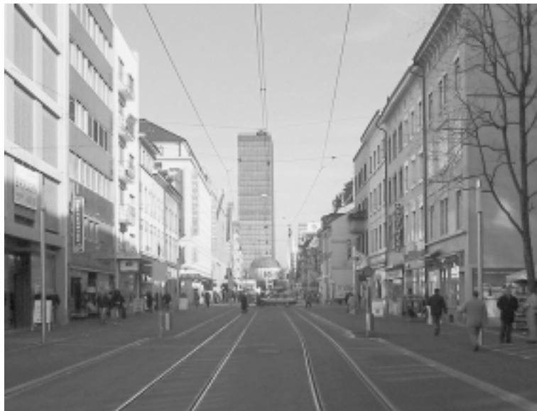
Nach dem Umbau der Clarastrasse dient diese als reine Fuss- und ÖV-Achse zwischen Innenstadt und Messe.
