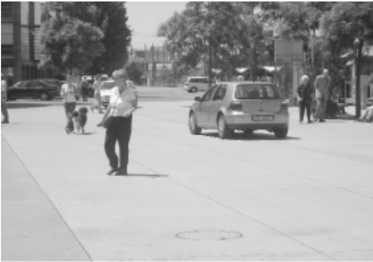
Der Bahnhofplatz in Baar wird als einheitliche Fläche von Fassade zu Fassade in einer Ebene als Platz ausgebildet. Grossflächige Ortbetonplatten verleihen dem Platz Grosszügigkeit. Bild: «Fussverkehr Schweiz»
