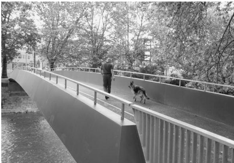
Eine neue Verbindung für die FussgängerInnen über SZU-Gleise und die Sihl verkürzt die Wege: Herterbrücke und Hertersteg. Die beiden Brücken schliessen eine wichtige Lücke im städtischen Wegnetz und schaffen eine neue Verbindung für den Fuss- und Veloverkehr zwischen Zürich Enge (Hürlimann-Areal) und Wiedikon (Sihlhölzlianlage).
