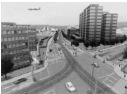
Visualisierung der künftigen Haltestelle Leutschenbach. Heute steht hier das Airgate, das Oerlikerhus und das Messeparkhaus. Geplant und im Bau sind der Sunrise-Tower, das Geschäftshaus Andreasstrasse sowie die Entwicklungsplanung Leutschenbach. Während auf der Thurgauerstrasse mehrspurige Fahrbahnen dominieren, soll das Leutschenbachquartier verkehrsberuhigt werden.
