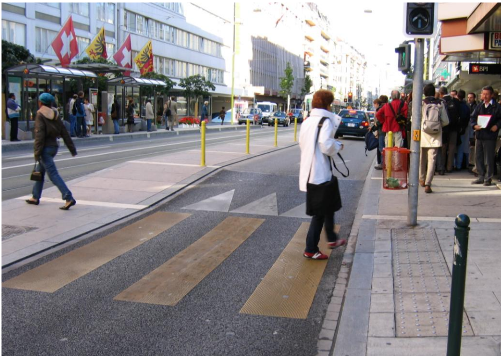
Haltestelle mit erhöhter Fahrbahn und Lichtsignalregelung. Zusätzlich ist hier ein schmaler Bereich zwischen Fahrbahn und Haltestellenkante mit Pfosten gesichert. Er dient nicht als Wartebereich. Haltestelle Môle, Genf (Foto: Fussverkehr Schweiz)
