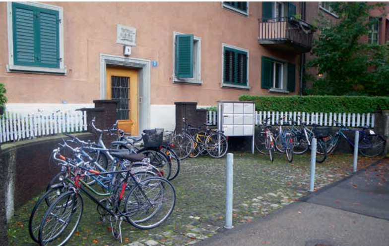
Die Veloparkierung sollte nah beim Hauseingang liegen. Siedlung Letten/Wasserwerkstrasse, Zürich. – Foto: BEP
