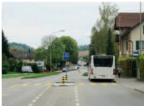
Eine Mittelinsel sorgt dafür, dass an der Bushaltestelle die Glattalstrasse sicher gequert werden kann.
