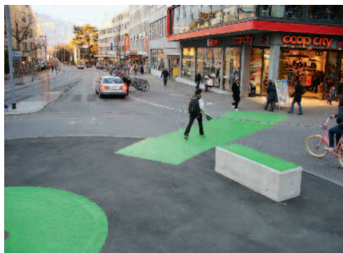
Der Kreisel am Alexanderplatz liegt in der Begegnungszone, es gilt daher zuerst Fussgänger- und dann Rechtsvortritt. Betonquader und eine auffällige grüne Markierung weisen auf die besonderen Verhältnisse hin.
