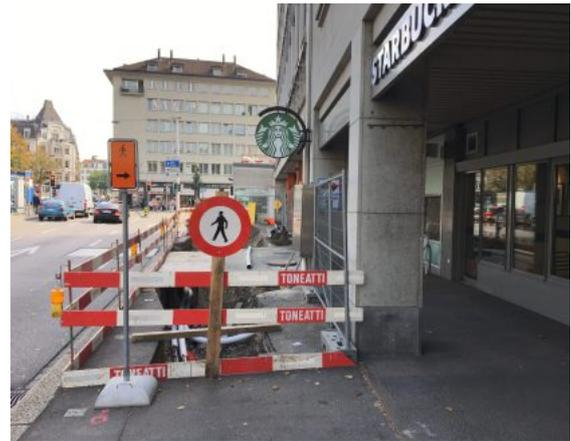
Vorbildlich: Eine sichere Verbindung hinter der Baustelle durch. Signalisation und Wegweisung sind korrekt und verständlich.
