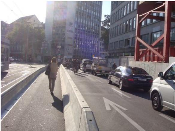
Vorbildlich: Die Fusswegumleitung ist mit massiven Beton-elementen gesichert.
