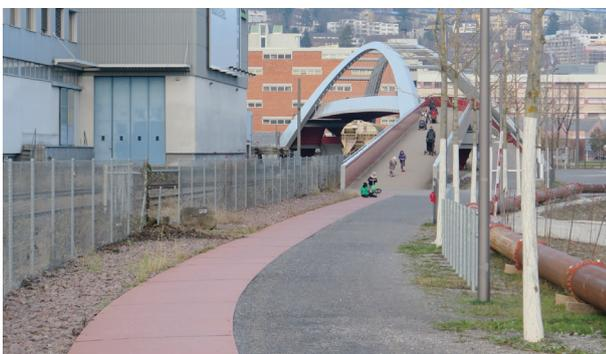
Zürich, Gleisbogen Zürich-West: Zwei Belagsarten, darunter ein rotes, mit Hartbelag ausgebildetes Band, das für den Veloverkehr gedacht ist. Die Trennung zwischen Fuss- und Veloverkehr funktioniert nicht wie geplant.
