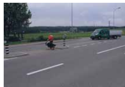
Possibilità di attraversamento insufficiente.
