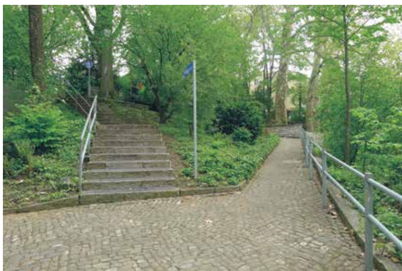
Il punto di partenza e il punto di arrivo di scale e rampe devono essere il più possibile ravvicinati.
