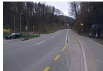
Mancanza di un punto di attraversamento.
