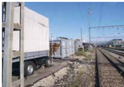
Mancanza di un percorso pedonale lungo il binario.
