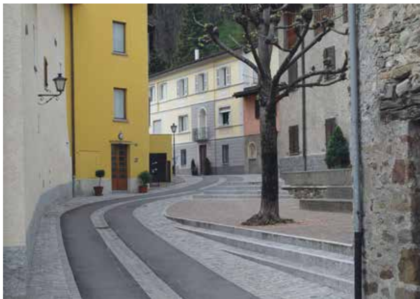
Riqualificazione dello spazio stradale in un centro storico.
