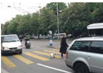
Le strisce pedonali attraversano due corsie di marcia nella stessa direzione senza adeguate protezioni.
