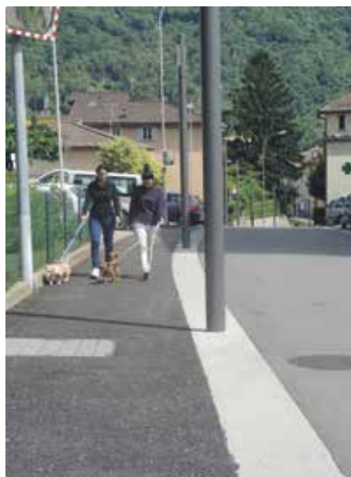
Marciapiede separato dalla carreggiata mediante elementi strutturali.
