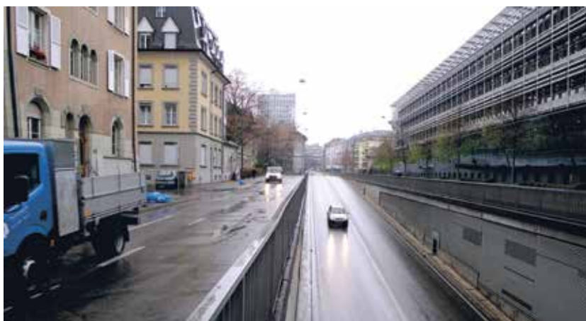
Effetto divisorio dovuto a elementi strutturali.
