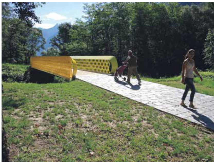
Un ponte costituisce un'elegante forma di collegamento tra il centro di una località e un quartiere periferico.
