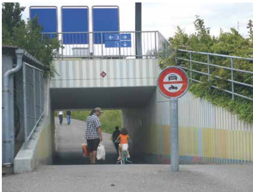
Il sottopassaggio rettilineo offre una buona visibilità.
