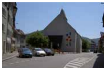
autoorientierte Platzsituation mit beengenden Verhältnissen für die Zufussgehenden.
