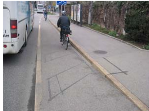
Induktionsschleife (fest verlegt)
